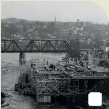
113 - 1935 Prêté jusqu'au : Le chantier de construction du supermarché Steinberg, rue Frontenac en 1955. Le vaste commerce repose sur plus d'une quarantaine de poutres élevées à même la rivière Magog. Collection Gérard Auray. Musée d'histoire de Sherbrooke.
